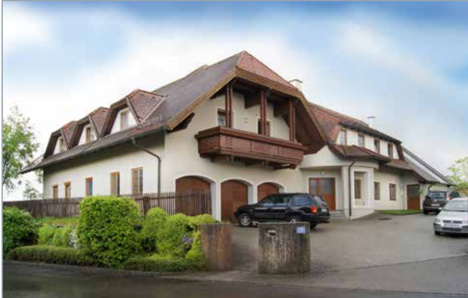
6 Wohnungen in Sierning, Bahnhofstr. 30
