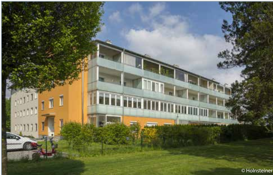
Wohnpark St. Georg / 35 Wohnungen in Bad Hall, Parkstr. 7
